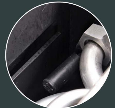
Il livellostato, abbinato alla centralina elettronica, permette di segnalare l'abbassamento del livello dell'acqua nella caldaia. Il tubo di scarico troppo pieno costituisce un sistema a vaso aperto che garantisce la sicurezza.
