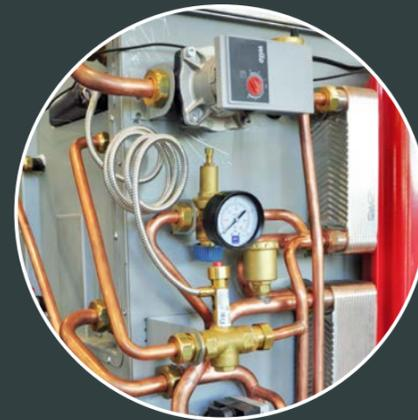
Sistema di sicurezza con valvola di scarico termico integrato.
