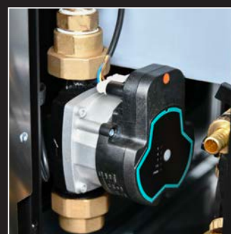
Pompa per circuito di riscaldamento
