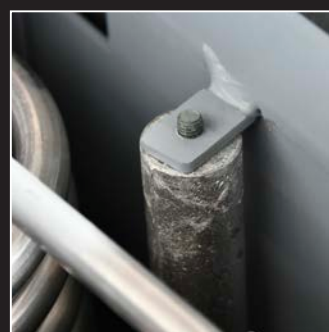
Anodo sacrificiale in magnesio per una maggiore protezione della caldaia
