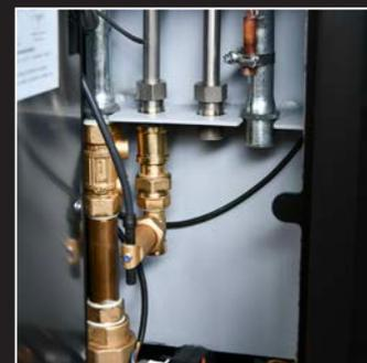
Conexiones de caldera sencillas mediante tubos flexibles
