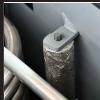
Ánodo de protección de magnesio para proteger mejor la caldera
