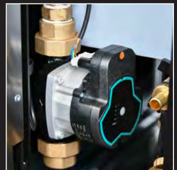
Bomba para circuito de calefacción
