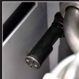
Interruptor de nivel para controlar el nivel del agua de la caldera
