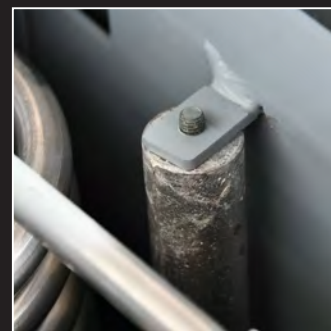
Magnesium-Schutzanode zum Schutz des Heizkessels
