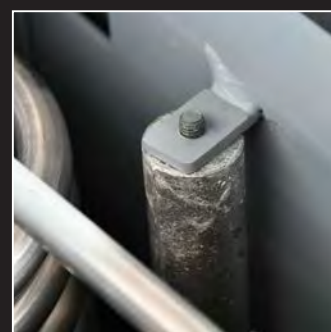
Magnesium-Schutzanode zum Schutz des Heizkessels
